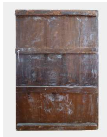
2.3 a, b, c, d Detalls de les alteracions i procés de protecció de la taula 5728, Enterrament de Crist
