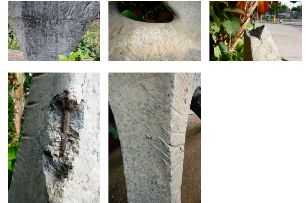
28.3 Detalls de les degradacions de l'escultura. Esquerdres, pèrdues de suport, oxidació de l'ànima de ferro i pintades de grafitis
