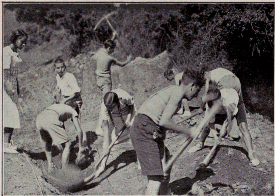
Excavant la nova piscina
