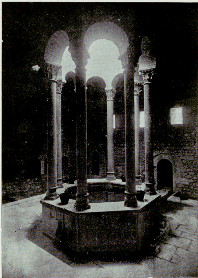
Fig. 5. — La piscine, dans la grande salle froide. On voit dans les murs les niches pour les vêtements et la porte menant aux salles chaudes.
