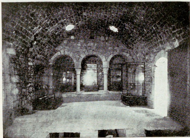
Fig. 10. — La salle des bains de vapeur, avec une alcôve.
