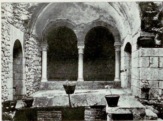
Fig. 11. — La troisième salle chaude, avec une des alcôves et l'entrée d'une niche. En bas, les piliers de l'hypocauste.
