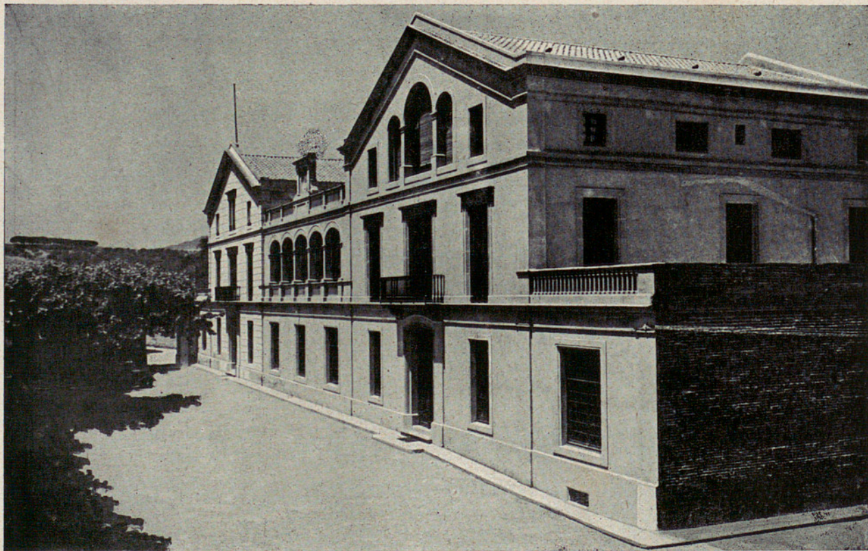
- Vista exterior del edificio escuela
