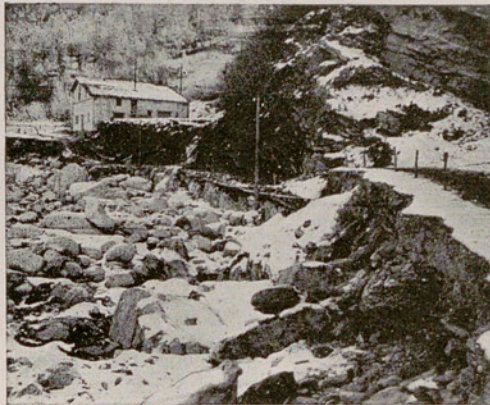
Fig. 16. — La carretera dels Molins a Cabdella, destruïda a 1 km. dels Molins.
