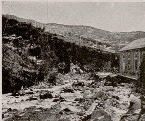
Fig. 19. — Aglomeració de desferres a la resclosa de La Plana (Molins). Vista aigua amunt de la resclosa.
