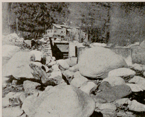
Fig. 20. — Aglomeració de desferres a la resclosa de La Plana (Molins). Vista aigua avall de la resclosa.
