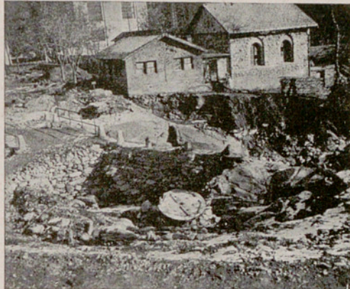
Fig. 17. — Sotscavació del terreny a la Central dels Molins.
