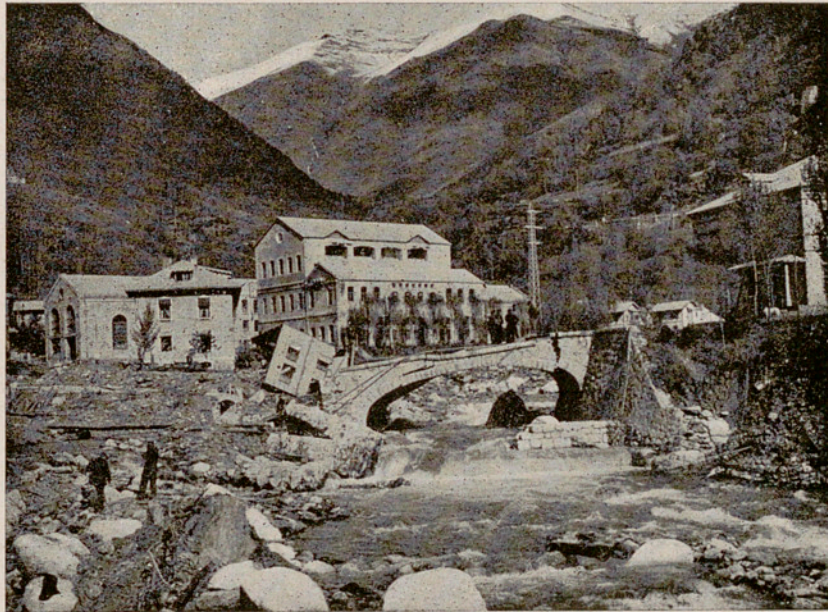
Fig. 11. — El campament de Cabdella, després dels aiguats d'octubre del 1937.
