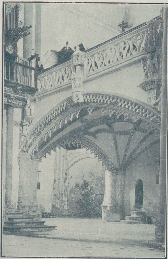
SAN HIPOLITO: Bóveda rebajada del coro.—S. HIPOLITO: Voute surbaissée du chœur. S. HIPOLITE: Choir's abated vault.
