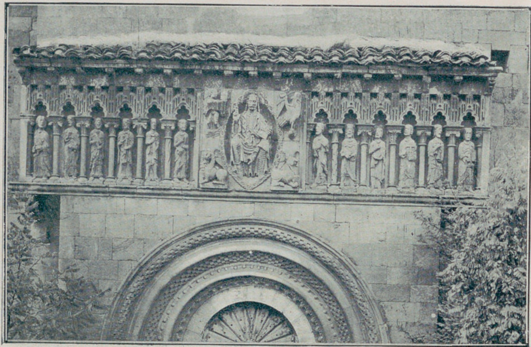
Detalle del pórtico de la iglesia.—Détail du portique de l'église.
