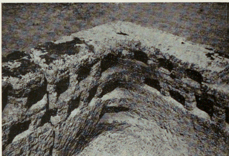
Uno de los ángulos de la terraza superior con los orificios para la sustentación de las vigas de la cubierta.
