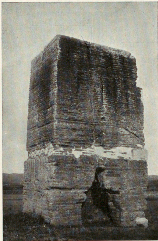
Parte posterior del monumento con el boquete abierto para utilizar su parte inferior como cabaña,
