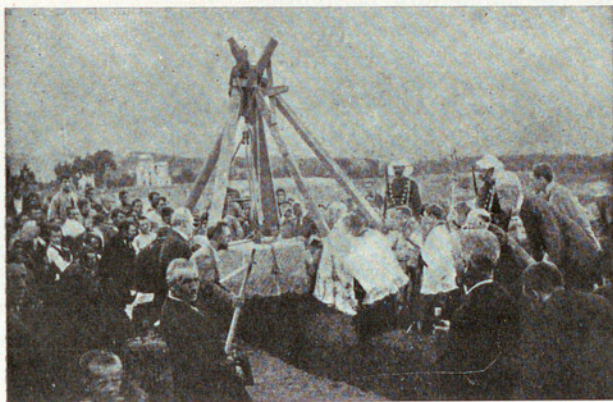
30 Junio 1894. Impresionante colocación de la primera piedra del Colegio
