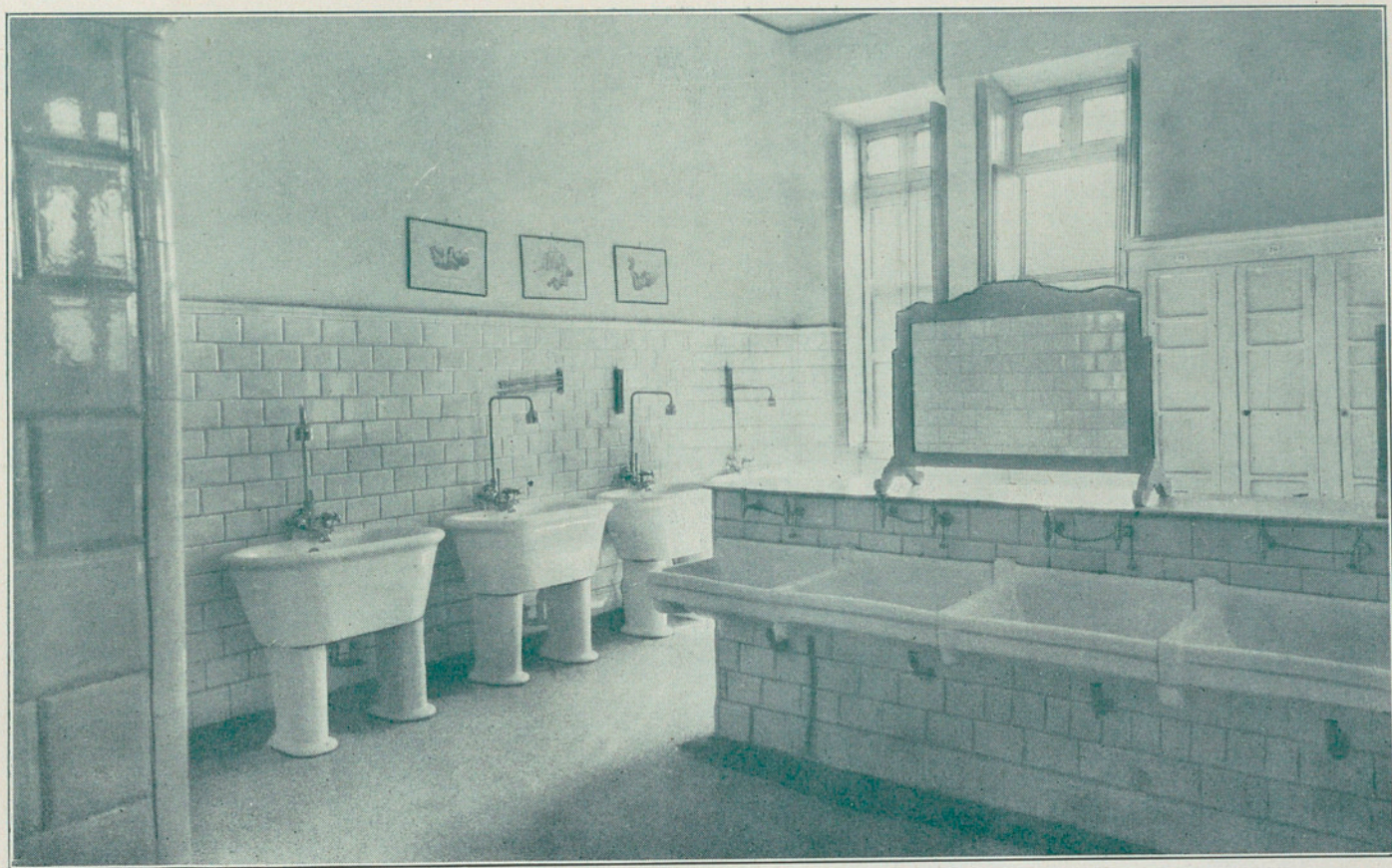
Sala de aseo (parcial)
