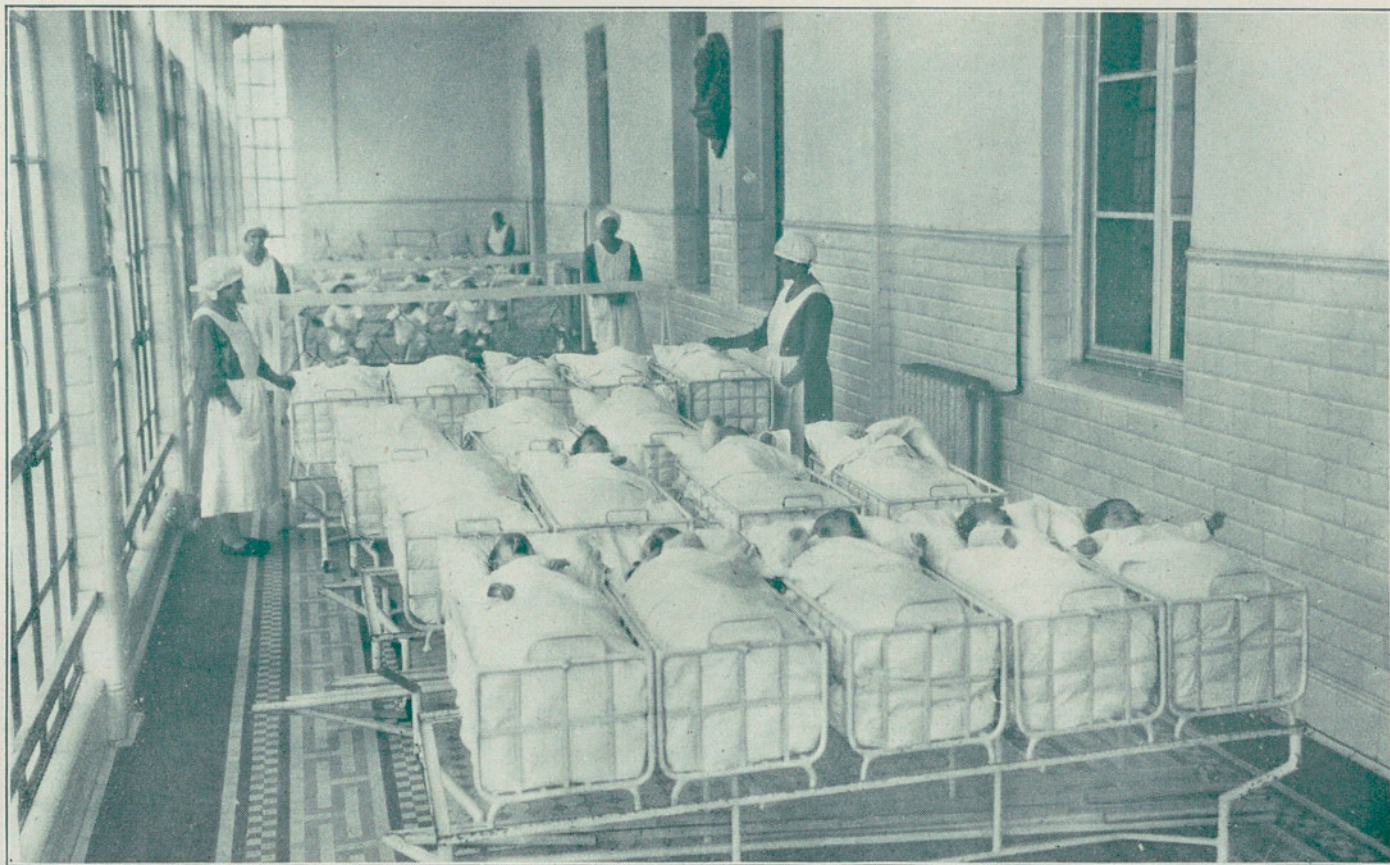
Galeria helioterápica (parcial)
