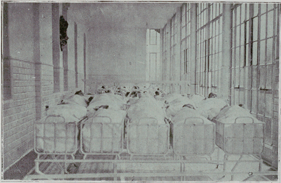
INTERIOR DE LA GALERIA HELIOTERÁPICA
