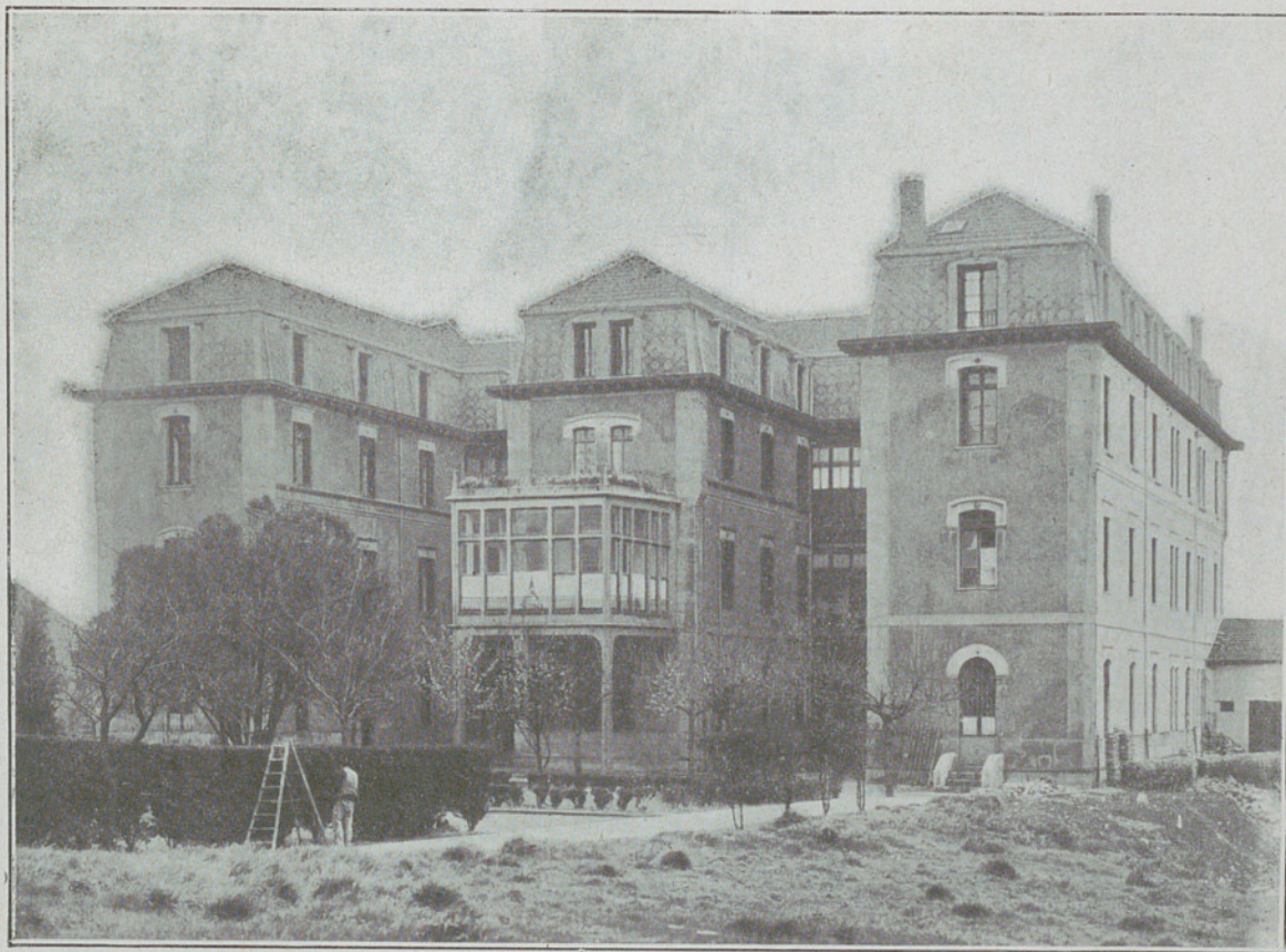
FACHADA POSTERIOR DEL EDIFICIO
