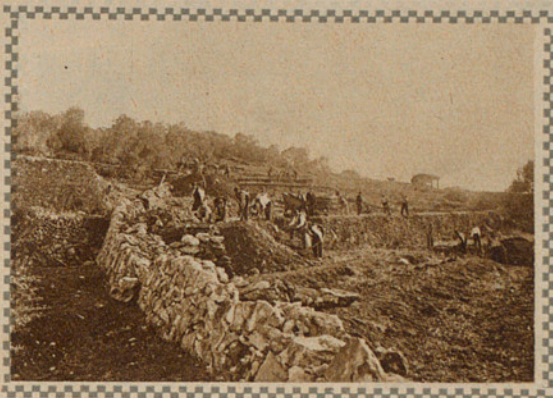
Iniciando la construcción de un viraje
