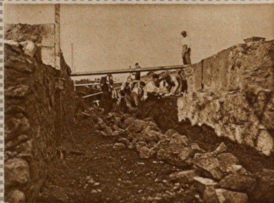
Construyendo el más pequeño paso inferior de la pista
