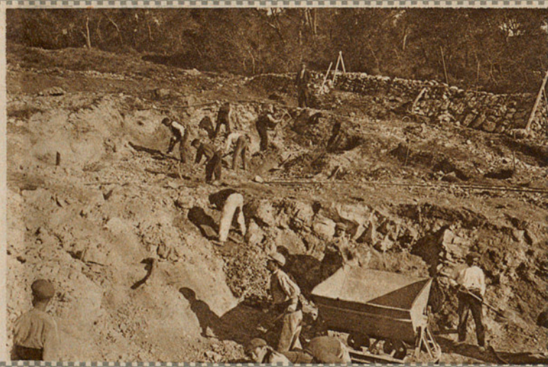
Excavación de un peralte
