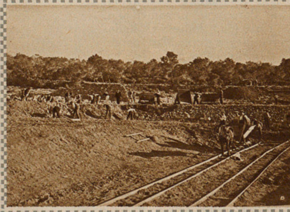
Tres vías de vagonetas operando en tres planos distintos
