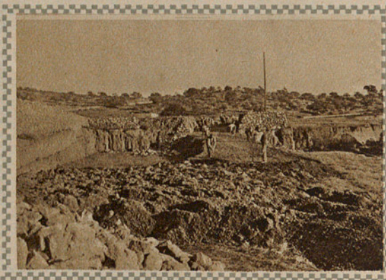
Construcción de una carretera interior del Autódromo
