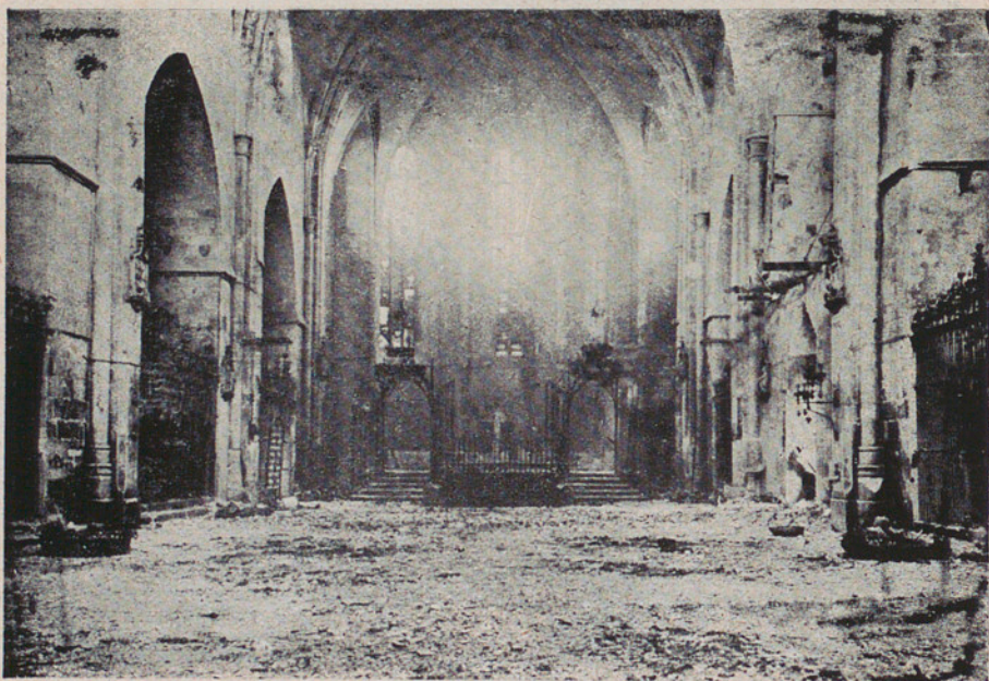
Vista desoladora de la nave, después del incendio.
