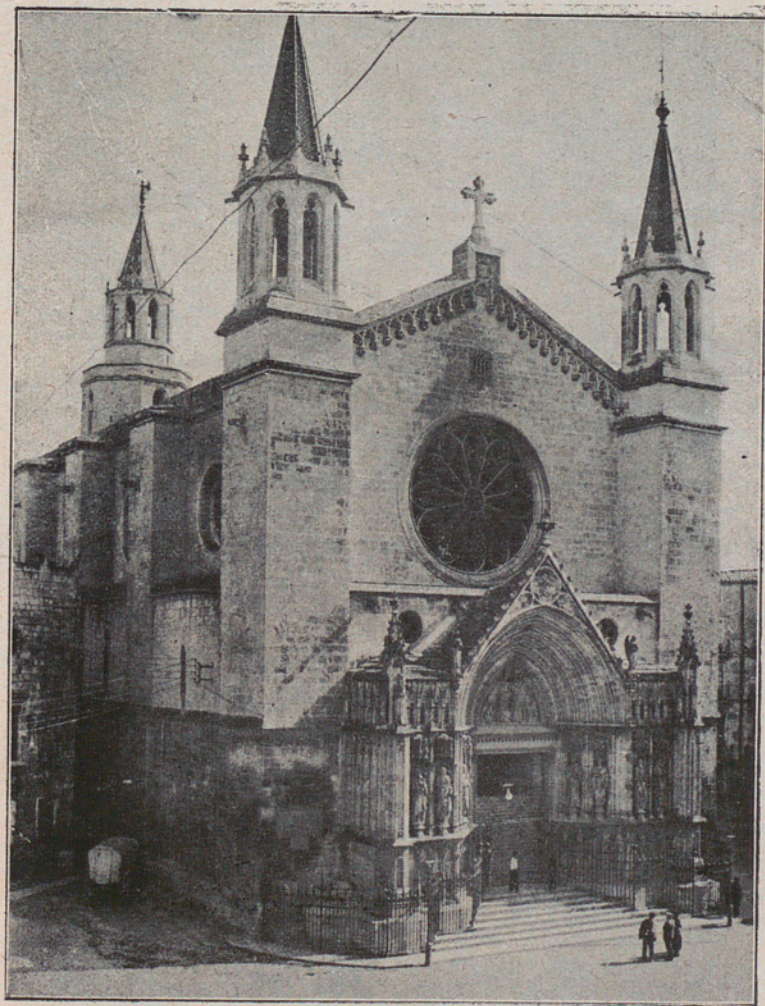
Fachada actual de la Basílica en la que se observan las huellas del incendio. La puerta se halla tapiada.
