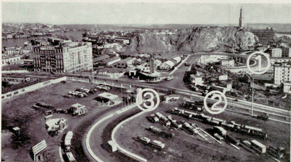
Fig. 10 — Risultati dello sbancamento di S. Benigno: il viadotto elicoidale (1), la strada per Val Polcevera e la Riviera di Ponente (2) e l'ingresso per la camionale di Serravalle (3) attraverso i piazzali di sosta degli automezzi (Rotalfoto, Milano)
