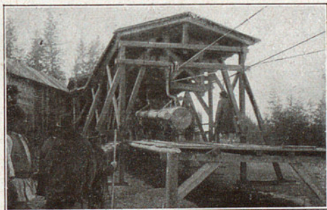
Estación de descarga
