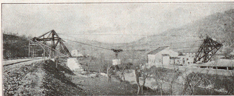
“ Blondin „ para el transporte de bloques de marmol de 20 toneladas de peso.
