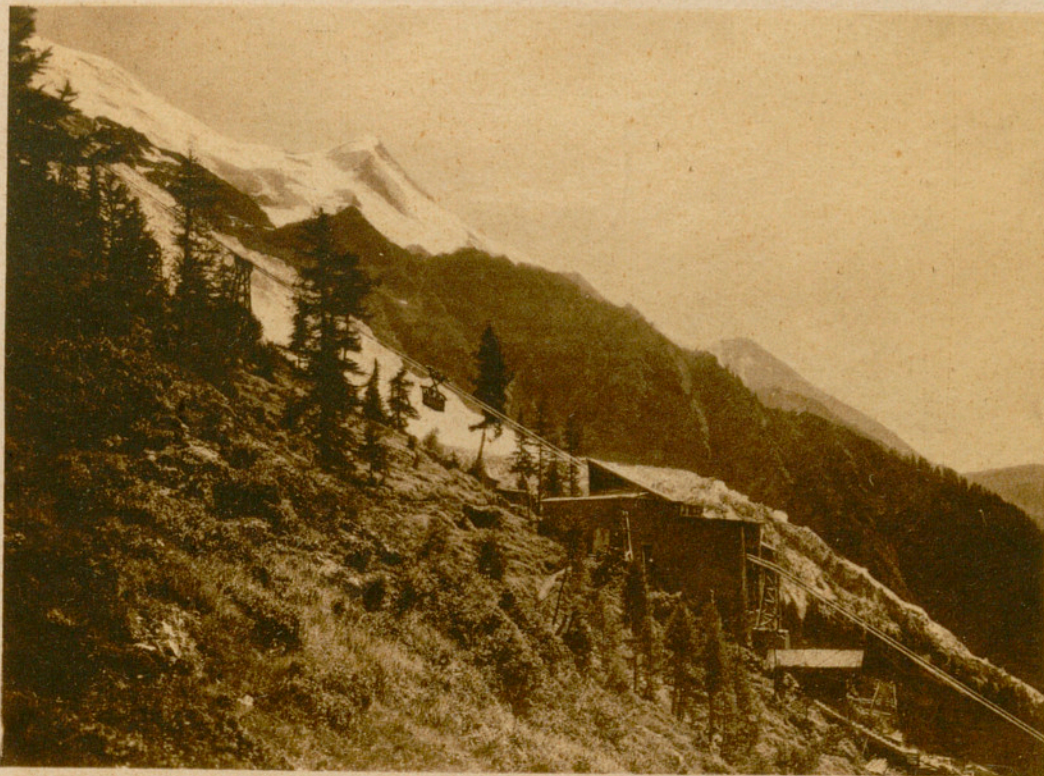
STATION LA PARA AVEC LES PREMIERS PYLONES DU DEUXIEME TRONÇON (1688-2431 METRES).
