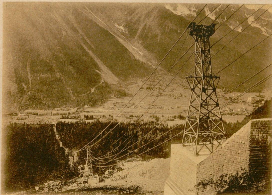
UN PYLONE ET LE PREMIER TRONÇON AVEC LA STATION LES PELERINS.
