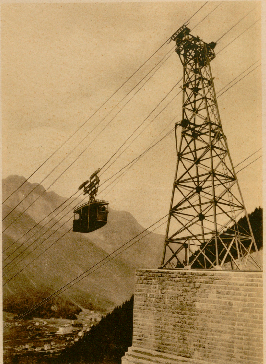
VUE LE LONG DE LA LIGNE SUR CHAMONIX.
