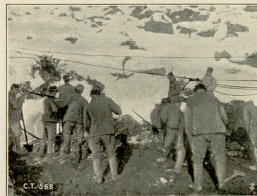
Epissures des câbles
