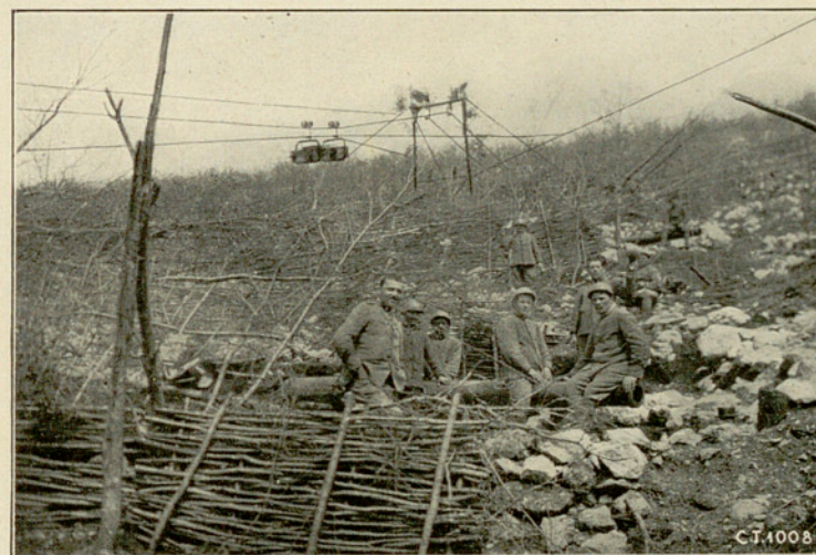
Station cachée dans une tranchée au service d'une batterie
