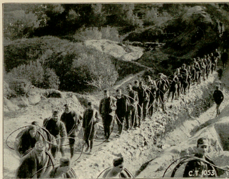
Transport d'un câble par une corvée de prisonniers
