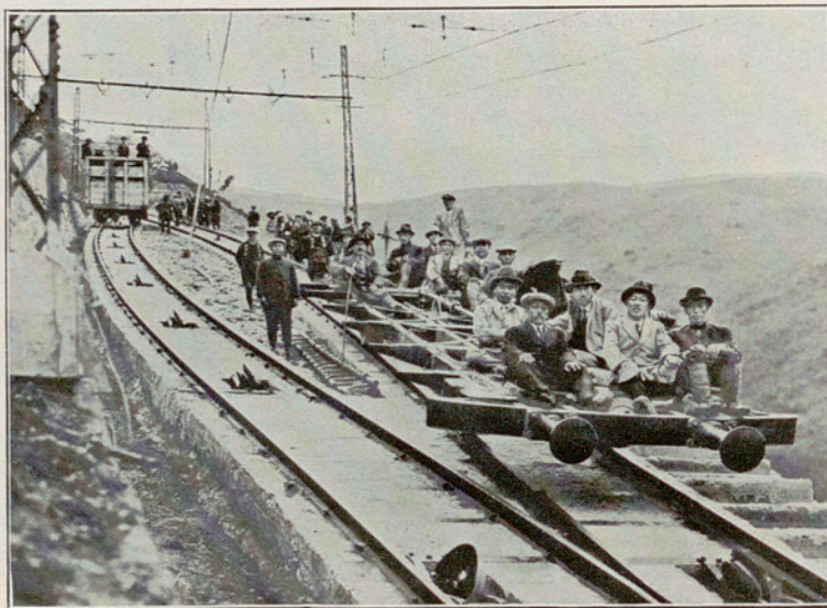
Fig. 17 Seilbahn Eizan, Japan Erste Fahrt mit den Wagen-Untergestellen
