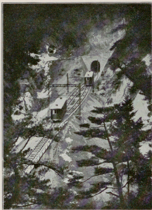
Fig. 28 Seilbahn Hiei, Japan Ausweiche
