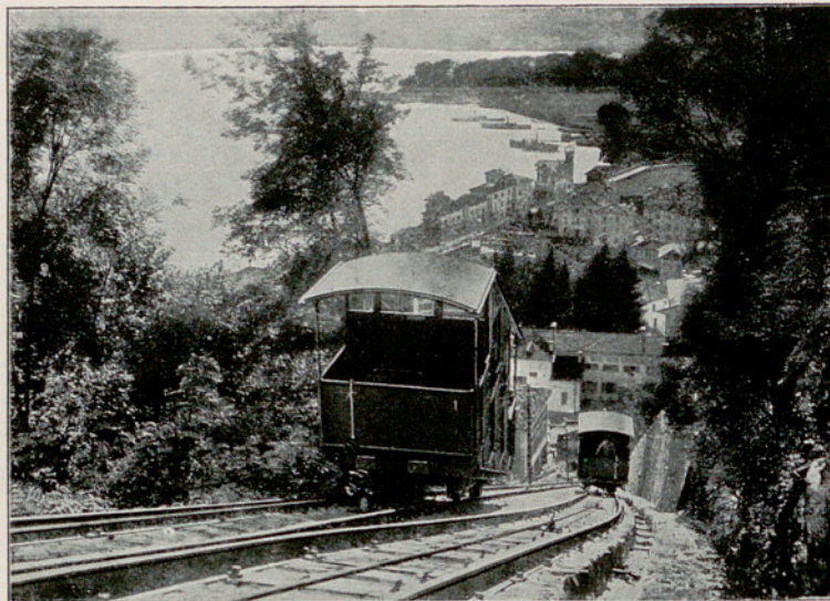
Fig. 8 Seilbahn Cassarate-Monte Brè, bei Lugano, Schweiz I. Sektion, Blick auf Castagnola
