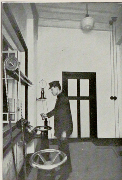
Fig. 31 Maschinenraum einer modernen Seilbahn in Japan
