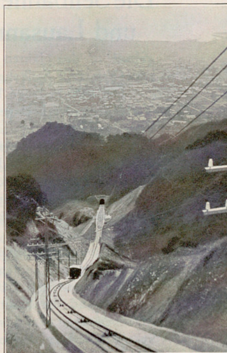
Fig. 23 Seilbahn Maya, Japan, Blick auf die Bahn und die Stadt Osaka
