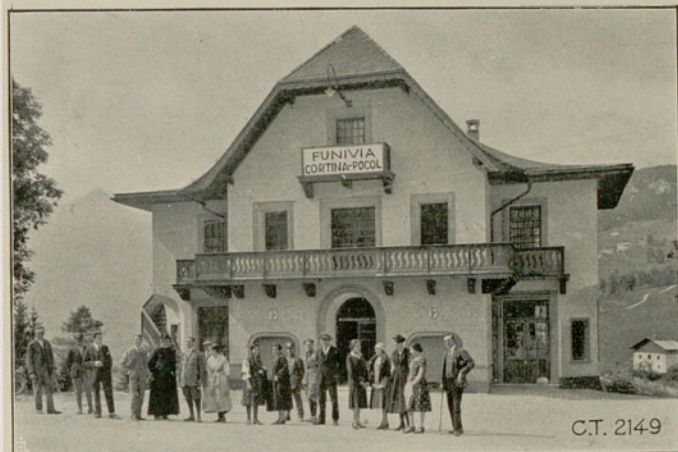
VUE DE LA STATION INFÉRIEURE
