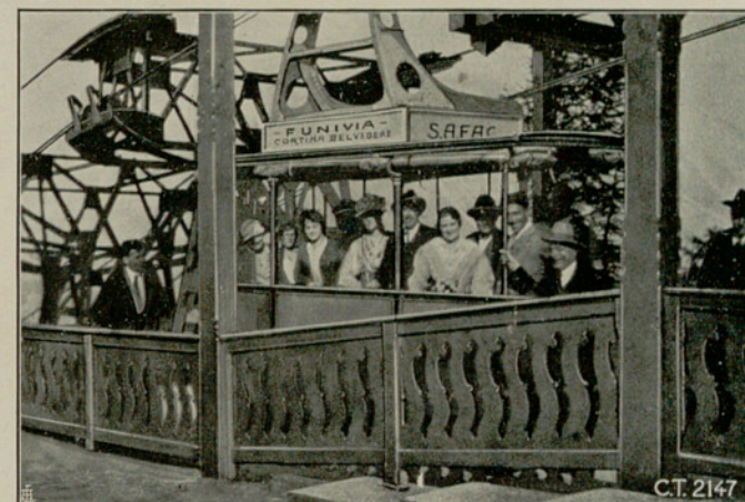
VOITURE À LA STATION SUPÉRIEURE
