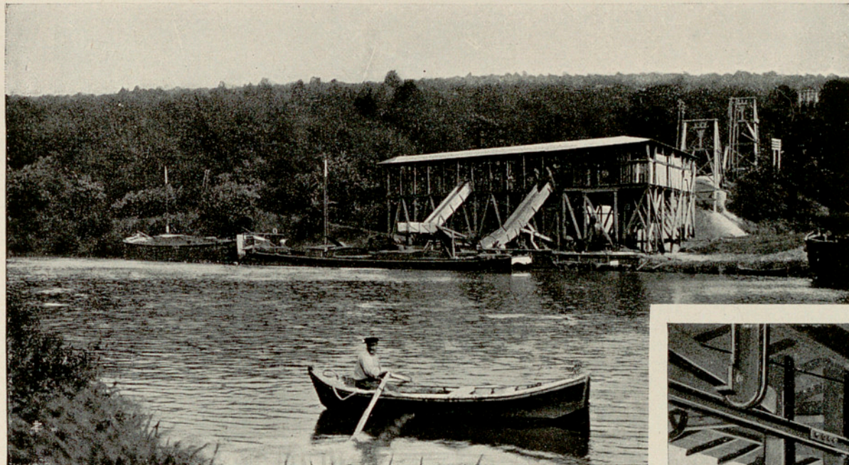
Fig. 95 — Stazione di scarico.
