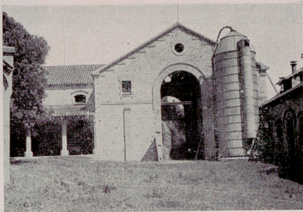
Adosado al espacioso henil está el gran silo metálico en el que se conservan los forrajes.
