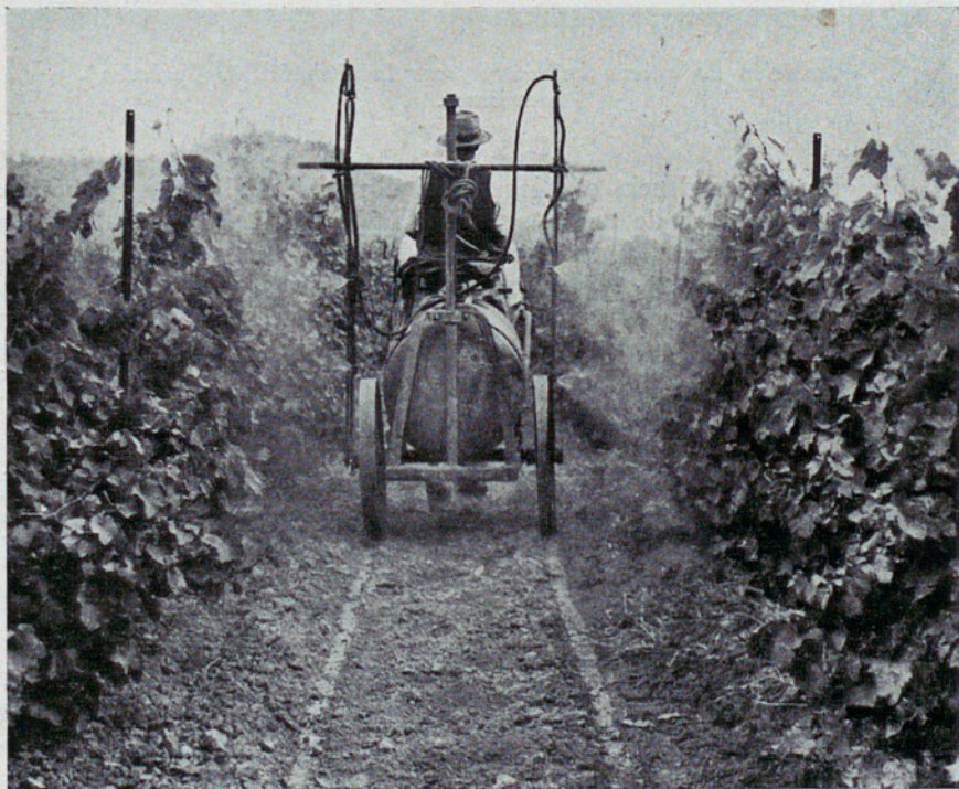
Una sulfatadora mecánica actuada por una caballería y utilizada para viñas extensas.
