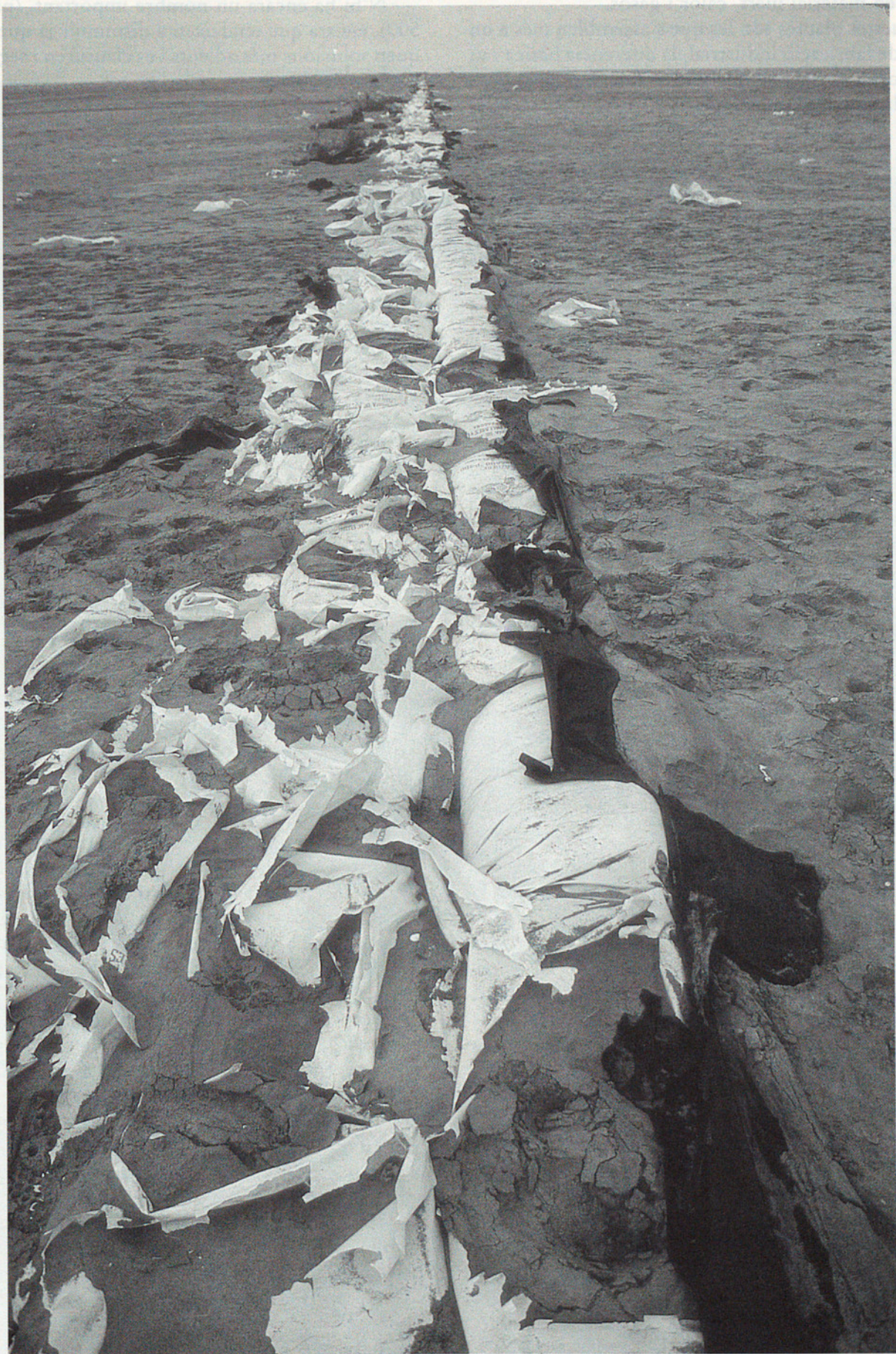
PROCÉS DE CREACIÓ D'UNA DUNA ARTIFICIAL A LA PLATJA DEL TRABUCADOR, DELTA DE L'EBRE
