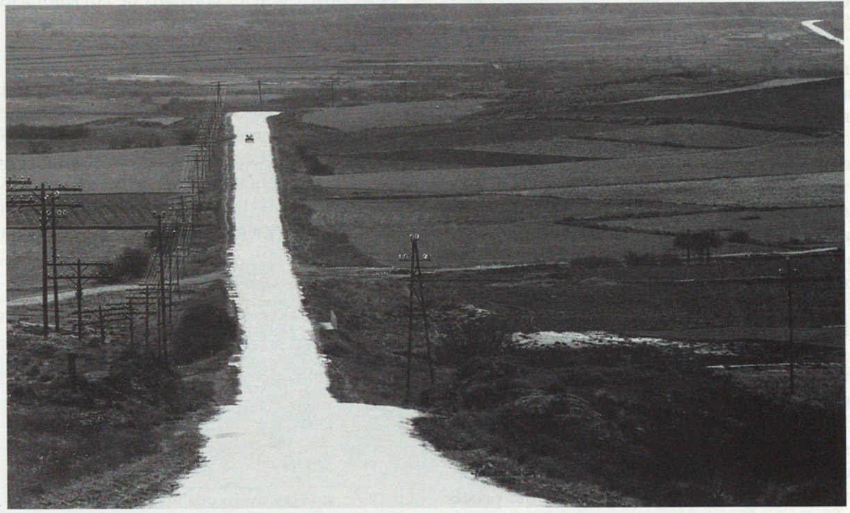
CARRETERA, A ARAGÓ
