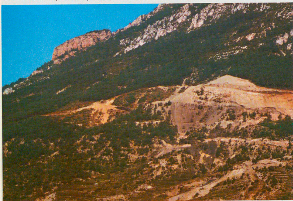
Ben visible, la destroça de l'explotació a cel obert.
