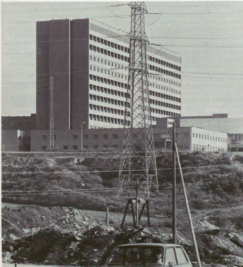
La nova Seguretat Social a la Carretera Sabadell-Terrassa.
