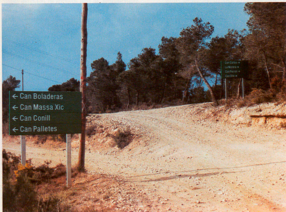
Reparació i senyalització en camins rurals al Bruc (Anoia), realitzada mitjançant un ajut de Caixa de la Diputació de Barcelona. La Caixa de Crèdit de Cooperació té per objecte
