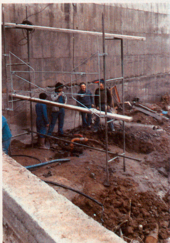
Construcció d'un mur de contenció a Navàs (Bages). (Foto: Servei de Cooperació Municipal).
