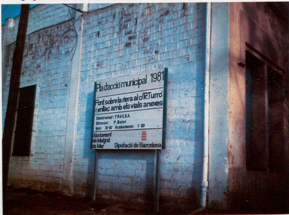
Construcció d'un pont a Malgrat de Mar (Maresme). Els Plans d'Acció Municipal de 1981 i 1982 afecten un total de 274
