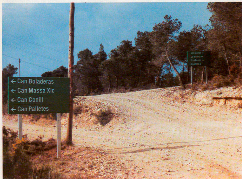
Reparació i senyalització en camins rurals al Bruc (Anoia), realitzada mitjançant un ajut de Caixa de la Diputació de Barcelona. La Caixa de Crèdit de Cooperació té per objecte
