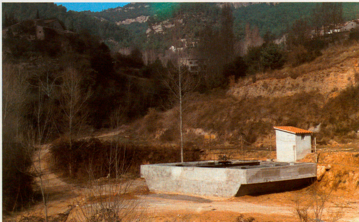
Depuradora d'aigües residuals a Gallifa (Vallès Occidental). (Foto: Ajuntament de Gallifa).
