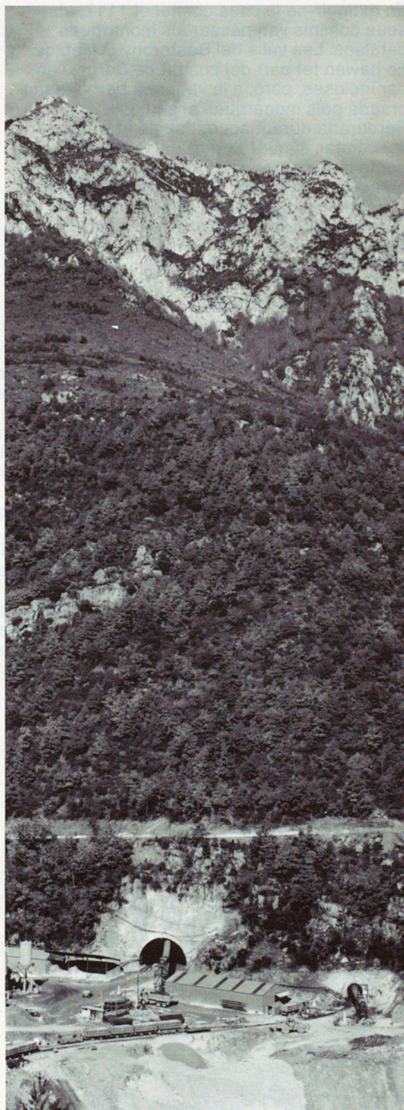
L'obertura del túnel del Cadi trencarà el singular aïllament berguedà i comportarà una millora important de les comunicacions intercomarcals.
