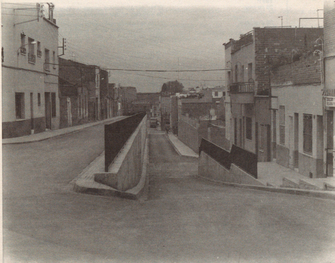
A conseqüència de la manca de planificació urbanística, s'han produït, i es produeixen, fets com aquest, de difícil solució i que acaben constituint un laberint de ciment armat. La fotografia presenta un aspecte del carrer de Monistrol, al barri del Poble nou.
