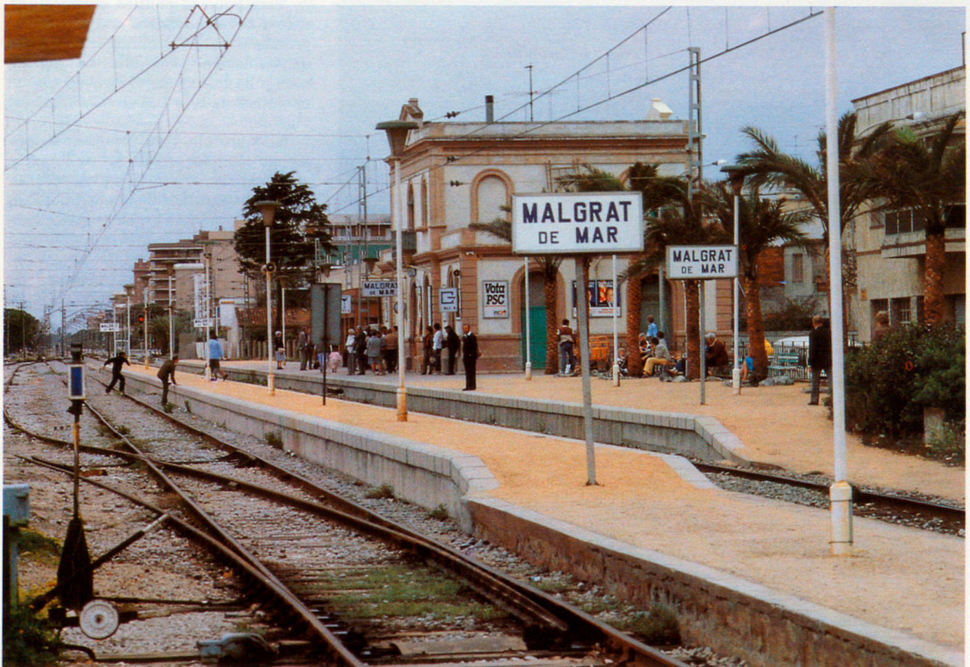
La via del tren trenca la relació entre el mar i els pobles de la costa.
