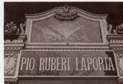
162 Barcelona-Barcelonès. Ronda de Sant Antoni. Estat actual, passable.
