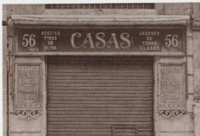
154 Barcelona-Barcelonès. Carrer Gran de Gràcia. Estat actual, molt descuidat.
