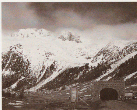
Boca sud del túnel de Viella, a la primavera. No entrà en servei fins l'any 1948.
