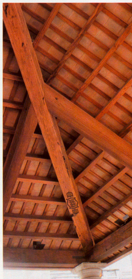
DIFERENTS ASPECTES DE L'ESTRUCTURA DE FUSTA A QUATRE VESSANTS DE LA PORXADA
