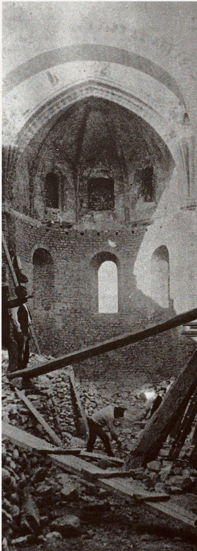
OBRES DE RESTAURACIÓ A L'INTERIOR DEL MONESTIR
