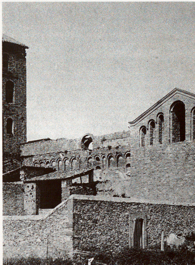
L'ABANS I EL DESPRÉS: OBRAS DE RESTAURACIÓ DELS ABSIS DEL MONESTIR DE SANTA MARIA DE RIPOLL (1886)
