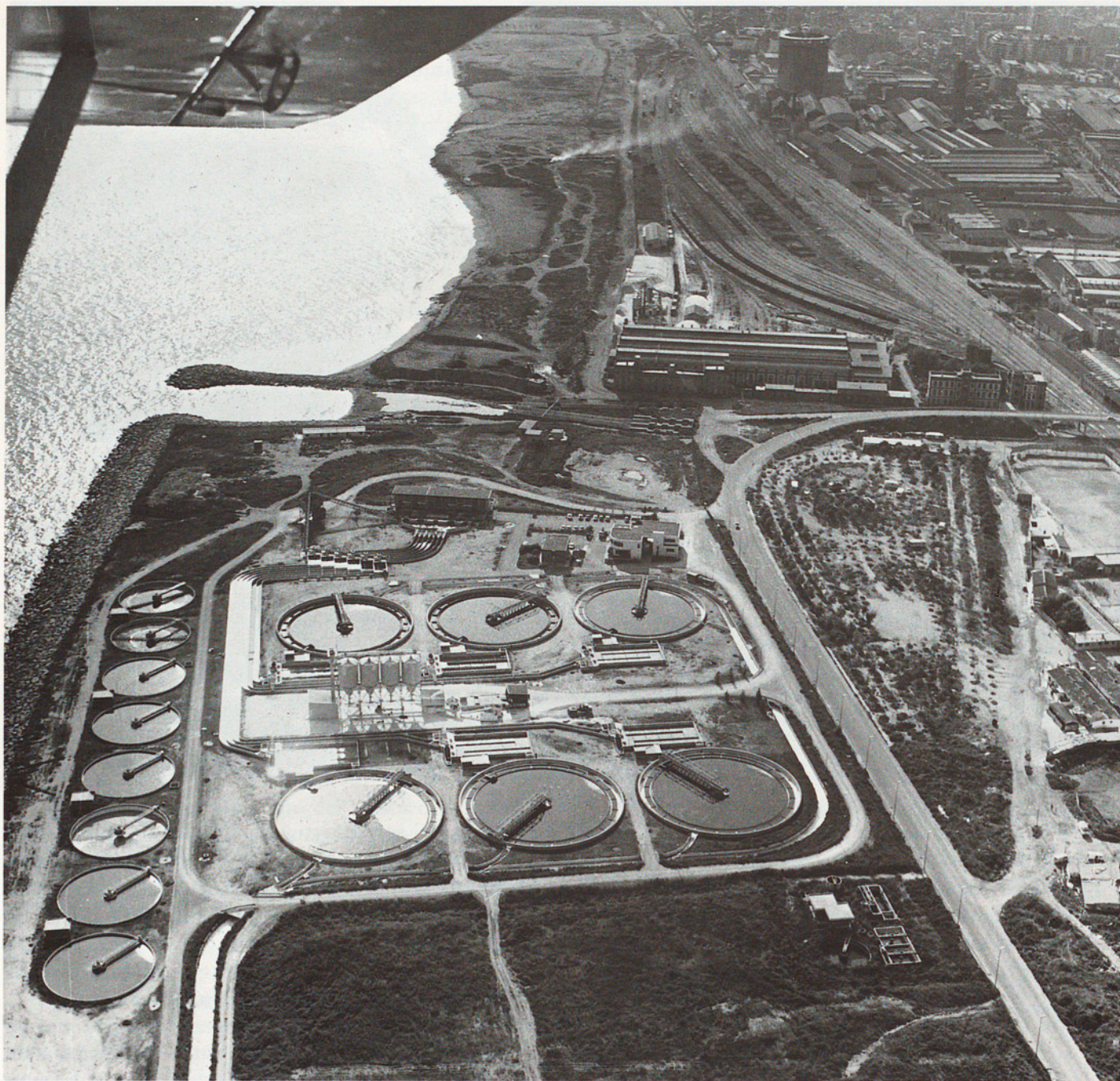
LA DEPURADORA DELS BESÒS VEURÀ AMPLIADA LES SEVES ACTIVITATS
