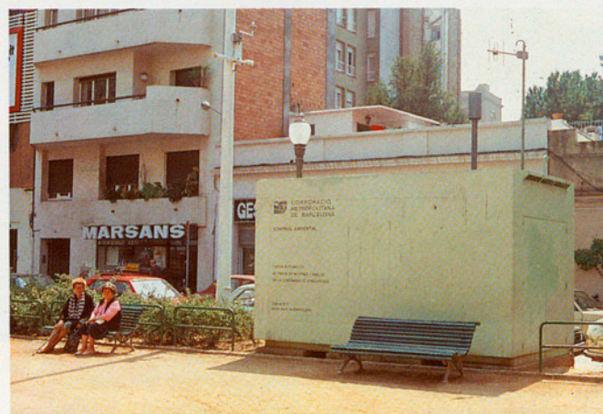
ESTACIÓ FIXA AUTOMÀTICA DE LA CONTAMINACIÓ ATMOSFÈRICA. PLAÇA MOLINA
