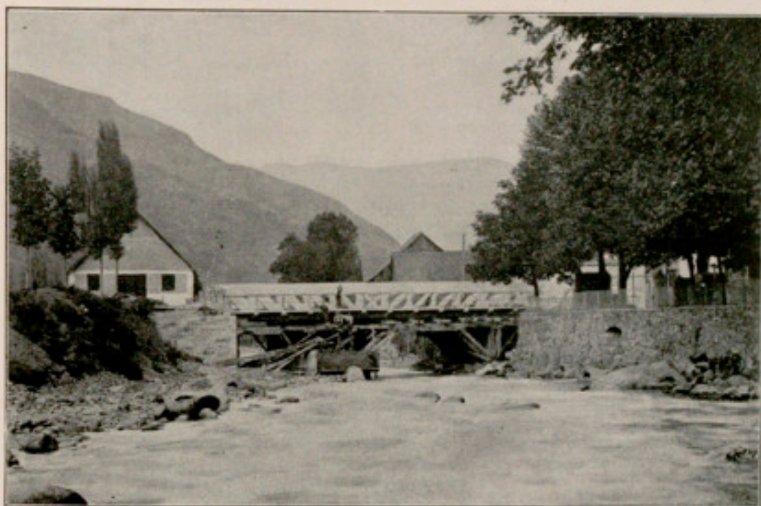
EL MATEIX PONT, EN DESMUNTAR ELS ANDAMIATGES
