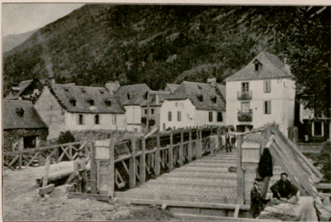
PONT SOBRE EL RIU GARONA, A LES (VALL D'ARAN), EN CONSTRUCCIÓ
