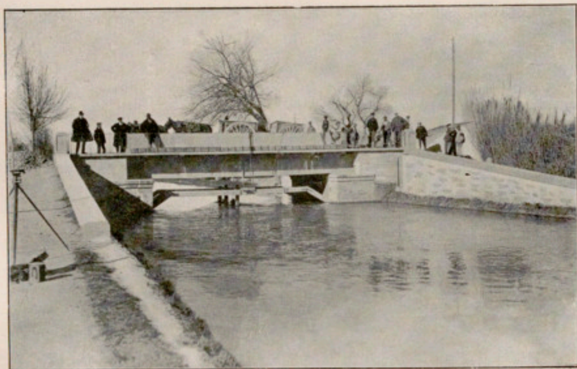
PROVES DEL PONT DE «LA CARROBA», SOBRE EL CANAL DE LA DRETA DE L'EBRE
