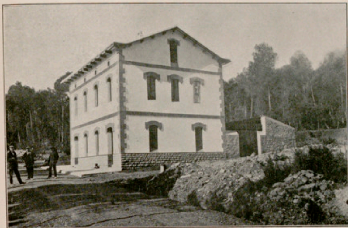
CASA PER A PEONS CAMINERS I DIPÓSIT DE MATERIAL, CONSTRUÏDA PER LA DIRECCIÓ D'OBRES PÚBLIQUES DE LA MANCOMUNITAT EN EL CAMÍ DE SANT MATEU DE BAGES A CALLÚS
