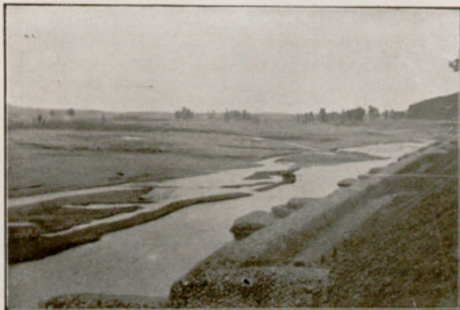
12. — Espigons de defensa, construïts en el tram corresponent a l'aiguabarreig dels rius Ripoll i Besòs
