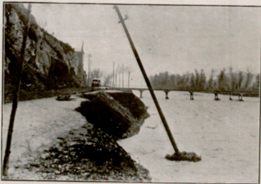
11. — Altra vista detallada d'un terraplè del mateix camí, malmès en l'aiguabarreig dels rius Ripoll i Besòs
