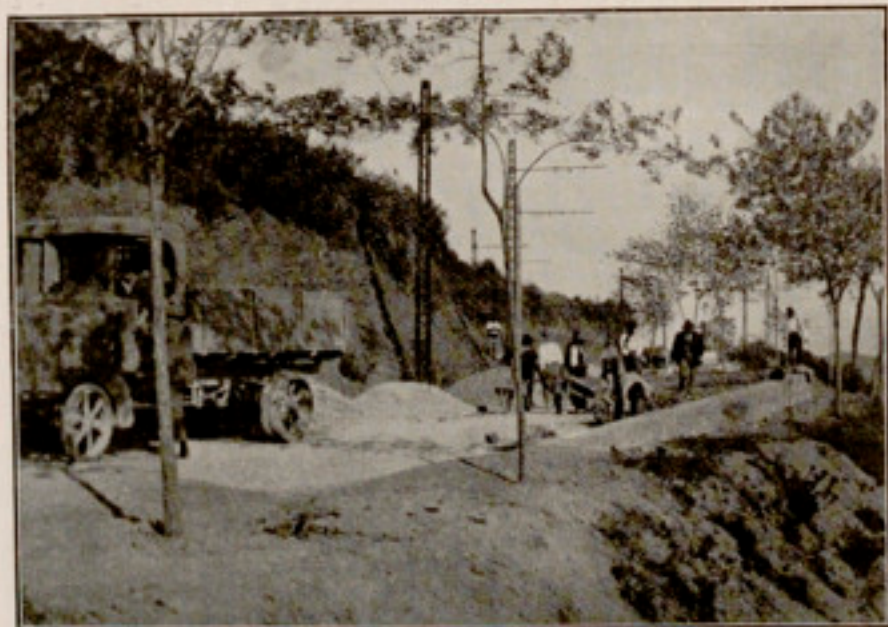
1. — Peraltament de les corbes mitjançant la construcció de murets de formigó i per a solament del ferm una capa de pedra en gros. (Carretera de Gràcia a Manresa.)
