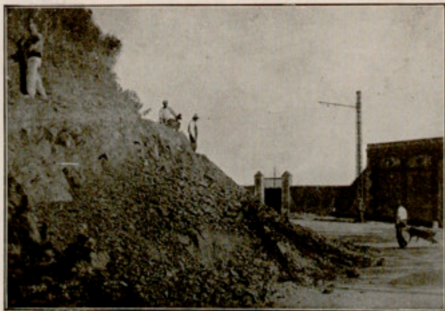
3. — Rebaixament de desmunt per a ampliar la visualitat en les corbes sobtades
