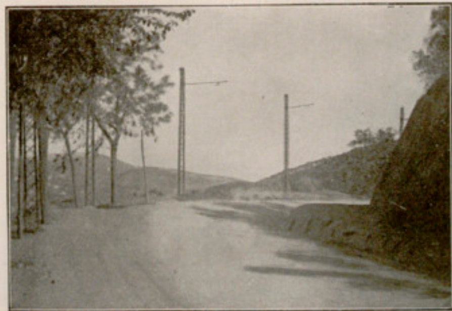
4. — Rebaixament acabat d'un desmunt en corba tancada i peraltada
