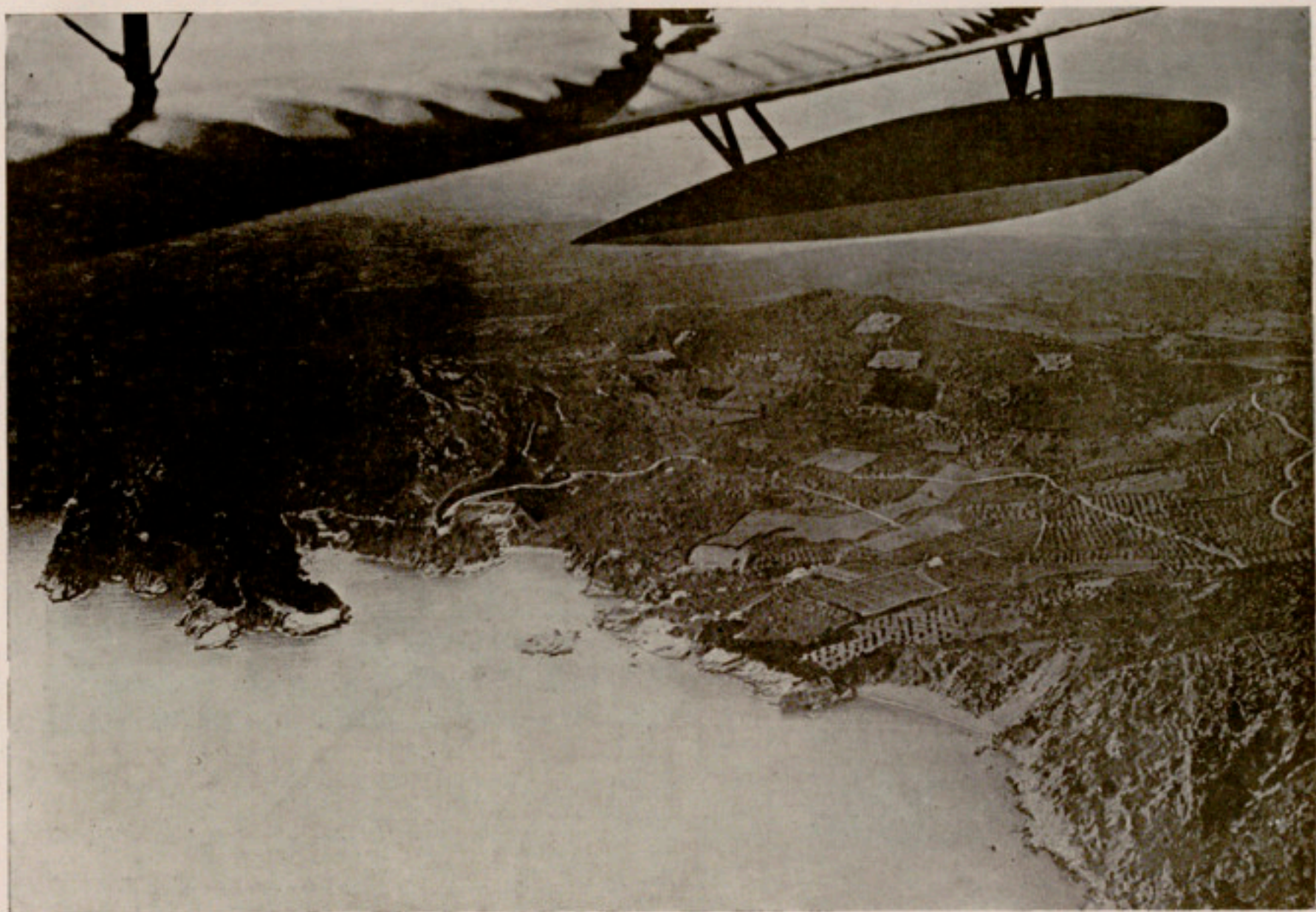
VISTA DE CONJUNT DEL CAMÍ MANCOMUNAL DE BAGUR A LA PLATJA D'AYGUABLAVA AMB RAMAL A LA DE FORNELLES
