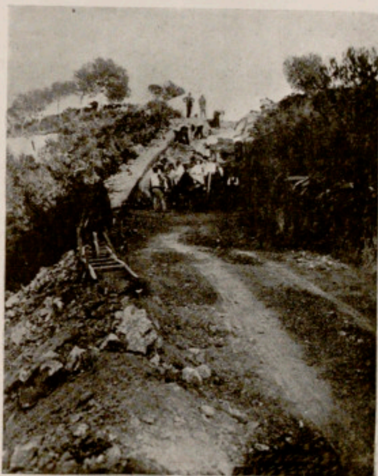
DESMUNT EN CONSTRUCCIÓ SOBRE LA CALA D'ELANYÀ
