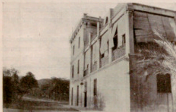
Fachada principal de Casa Tarrida
