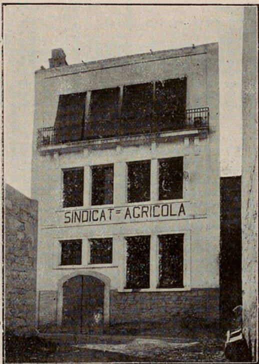
Fig. 50. — ARTESA DE LLEYDA : Edifici del Sindicat (posterior)
