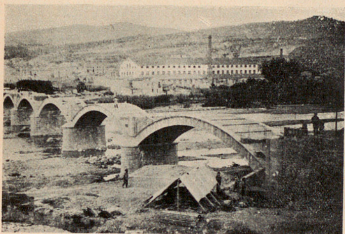
Pont en construcció sobre el Llobregat a Sant Vicens de Castellet
