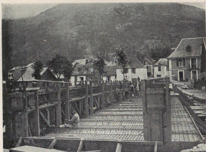
Pont de Les sobre el Garona, en construcció
