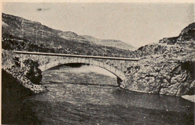
Pont del camí veïnal de Llimiana a la carretera de Balaguer a la frontera
