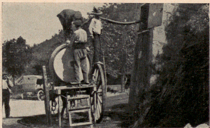
Carro bóta carregant directament de la conducció del dipòsit
