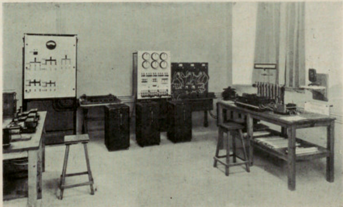
Instal·lacions per a la prova de comptadors i altres instruments de corrent altern i per a les proves magnètiques dels ferros
