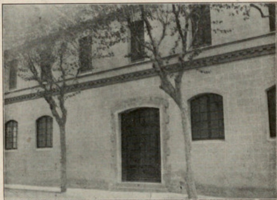
Fachada y entrada del edificio construido expresamente para el Laboratorio Textil y Acondicionamiento. En él están instaladas, además, las oficinas de Administración del Laboratorio General.
