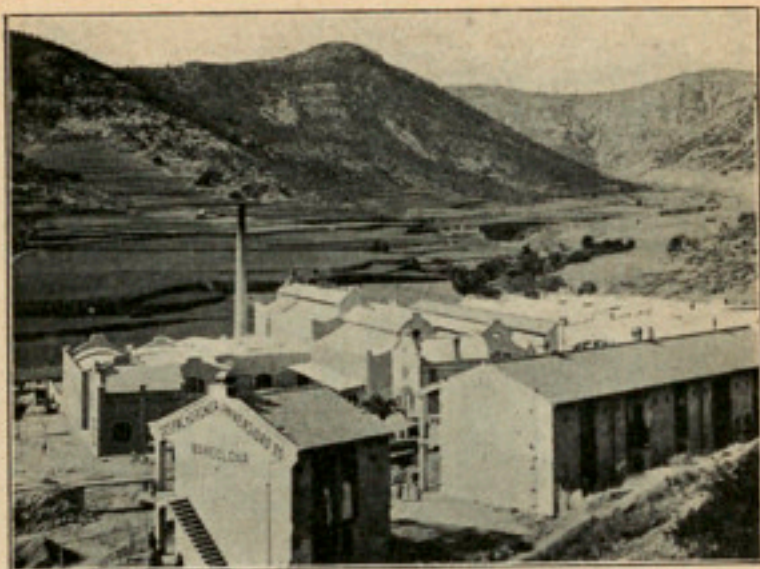
Fig. 39. — Fàbrica de ciment dels Srs. FRADERA I BUTSENS, en 1914. Deu anys després ha sigut amplada considerablement
