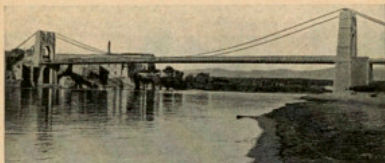
Fig. 5. — Pont penjant per damunt del riu Ebre, en Amposta, de 130 metres de llum, amb un ample de 4'50 metres, i dues cores laterals de 0'75 metres (en total 6 metres). La part més baixa de la plataforma està a uns 3'20 metres d'alçada per damunt de la riada del 25 d'octubre de 1907.
